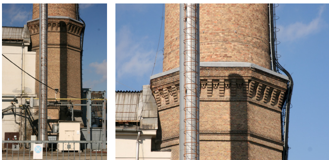
10-11. ábra Az ágyúgyári kémény nyolcszögletű lábazata.
