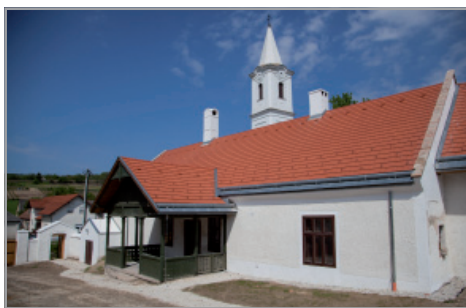
5. ábra: A felújított „Nivegy-ház” (fotó: Oláh Gergely Máté, 2016)
