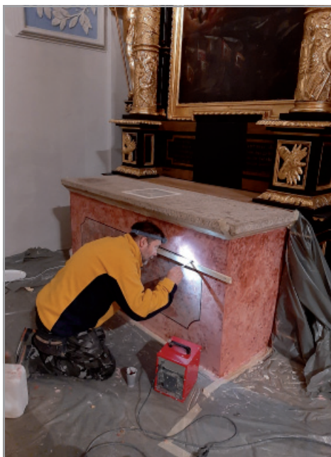
15. ábra: A stipes márványfestése
