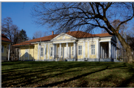
1. ábra: Az Algériai Nagykövetség épülete (fotó: Fogarasi Barbara, 2021)
