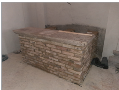
11. ábra: Az újrafalazott stipes a megtisztított és visszahelyezett menzalappal.
