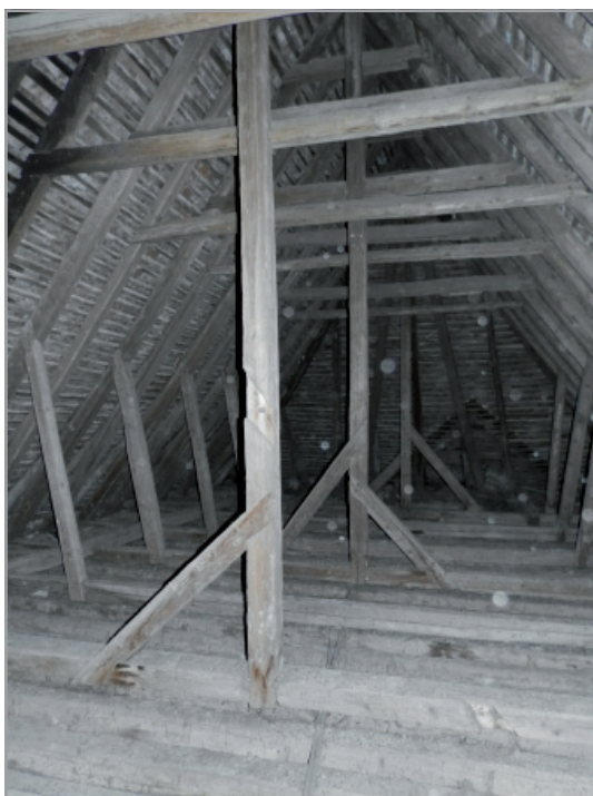
2. kép: A sepsimagyarósi ref. templom tetőszerkezete. (a szerző felvétele, 2015)
