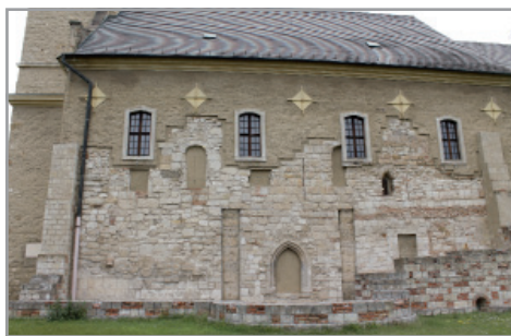
4. ábra: Déli homlokzat (saját felvétel)
