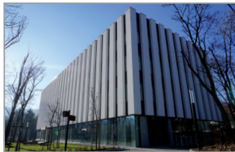
2. ábra: A MOMÉ Base épülete (fotó: Fogarasi Barbara, 2021)
