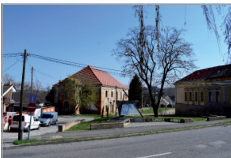
6. ábra: A Holokauszt-emlékmű helyén állt a zsidó iskola, amelyet rossz állapota miatt lebontottak. Az ózsinagóga eredetileg kevésbé volt látható az utcáfrontról
