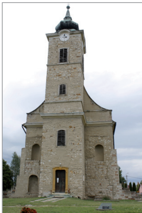
1. ábra: A templom nyugati homlokzata (saját felvétel)
