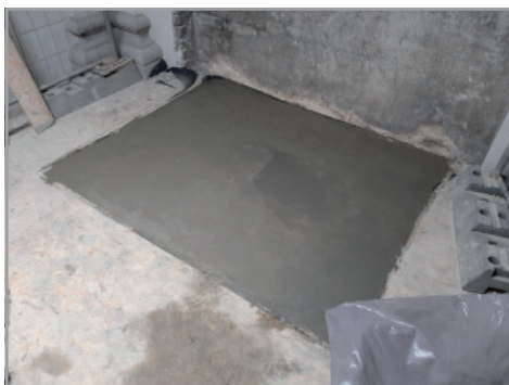
10. ábra: Az elkészült lemezalap
