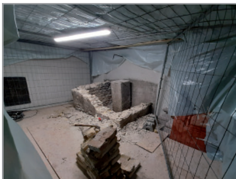
9. ábra: A téglafal elbontása
